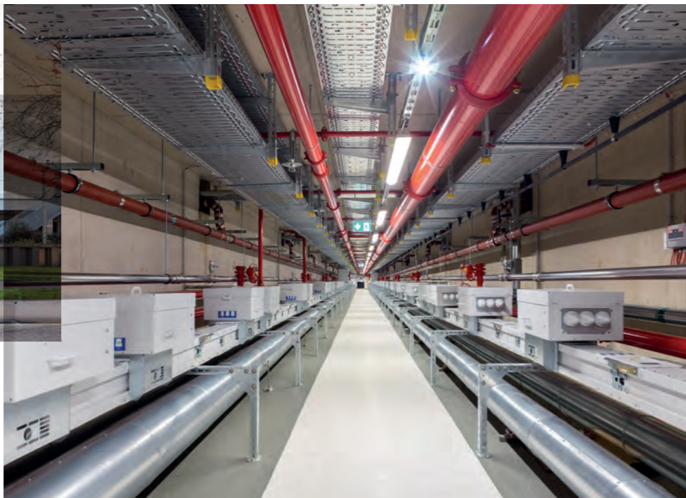
Die neue Versorgung der fertiggestellten Halle 1 folgt dem bewährten Prinzip eines Medienkanals unterhalb der Ausstellungsebene.
