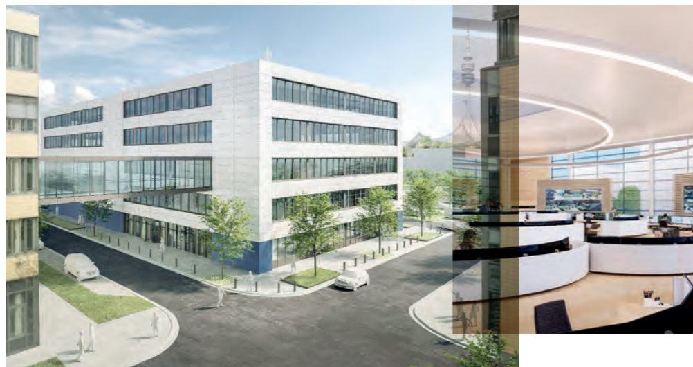
Der Neubau vereint wichtige Betriebsnutzungen der Münchner Verkehrsgesellschaft. Das Kernstück ist die neue Leitstelle.
