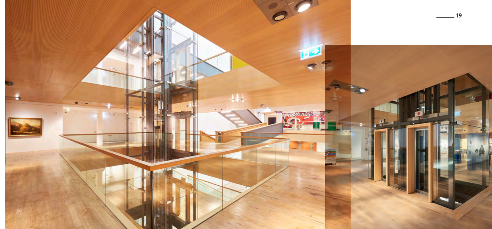
Blick auf den verglasten Fahrschacht im Herzen des Neubaus.
