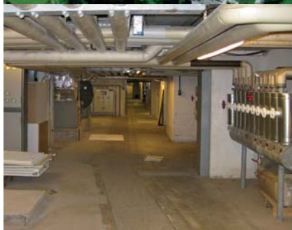
© Foto oben: Max-Planck-Institut © Foto unten: ZWP Ingenieur-AG
