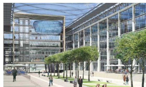
Innenansicht Mall (© Abb./Architekt: HPP, Köln; Bauherr: Grundstücksgesellschaft Bürohäuser Köln Rheinpark GbR, RheinEstate GmbH, Köln)
