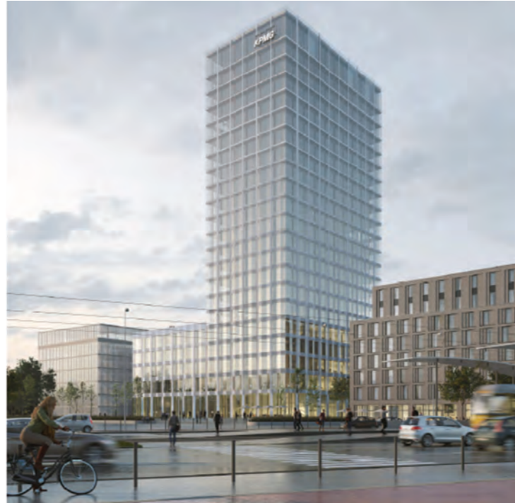
Leistungen: Planung (LP 1-6), Sanitärtechnik, Heizungstechnik, Raumluftechnik, Kältetechnik, Elektrotechnik, Nachrichtentechnik, Mess-, Steuer- und Regeltechnik, Gebäudeautomation, Feuerlöschanlagen Auftraggeber: CA Immo Deutschland Architekt: Allmann Sattler Wappner Architekten, München Visualisierung: © Artefactorylab für Allmann Sattler Wappner Architekten
