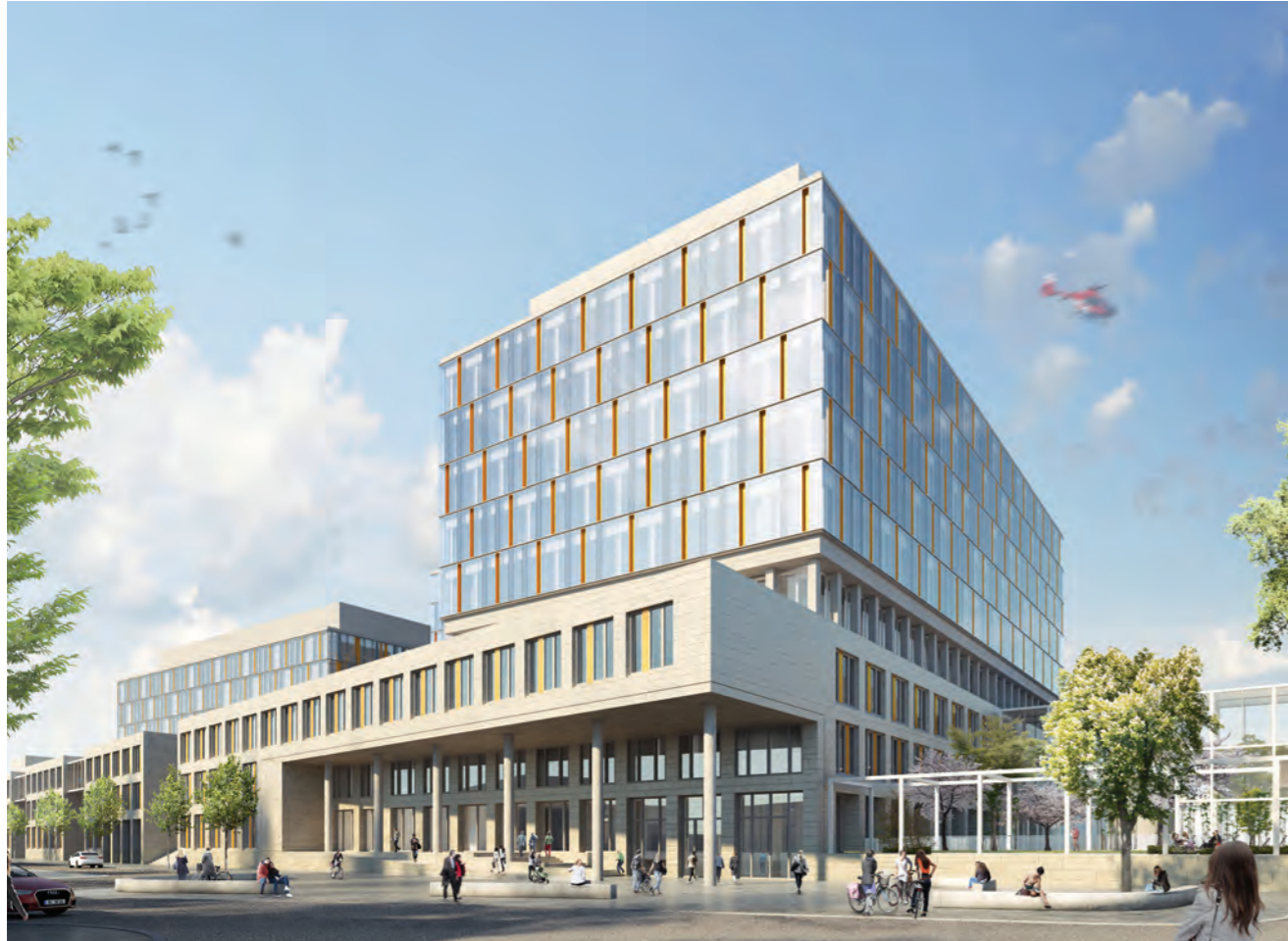
Leistungen: Planung (LP 1-5), Sanitärtechnik, Heizungstechnik, Raumlüftungstechnik, Kältetechnik, Elektrotechnik, Nachrichtentechnik, Fördertechnik, AWT-Anlage, Medientechnik, Feuerlöschtechnik, Gebäudeleittechnik Auftraggeber: gmp International GmbH, Aachen Architekt: gmp International GmbH, Aachen Visualisierung: © gmp International GmbH, Aachen
