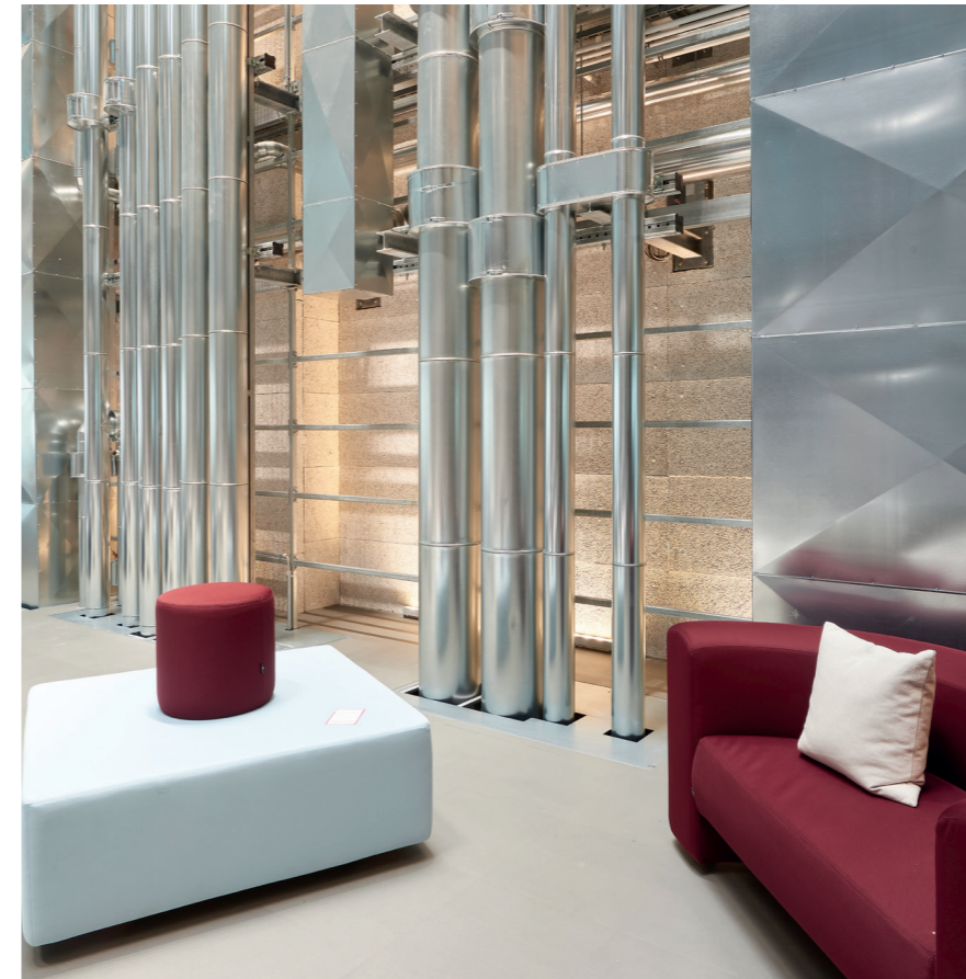
Die offen zugängliche Installationswand im Axel Springer Campus, Berlin.
